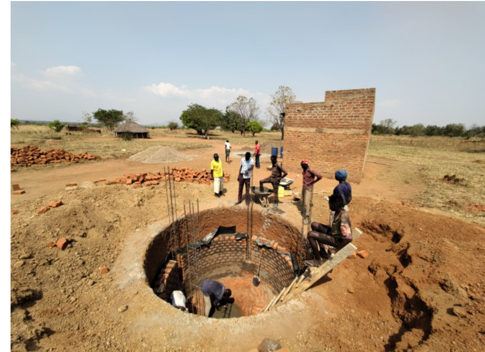
Video vom Wassertankbau
